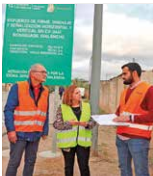
Visita a las obras. / EPDA
