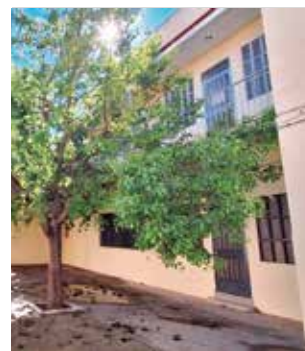
Antiguas escuelas. / EPDA
