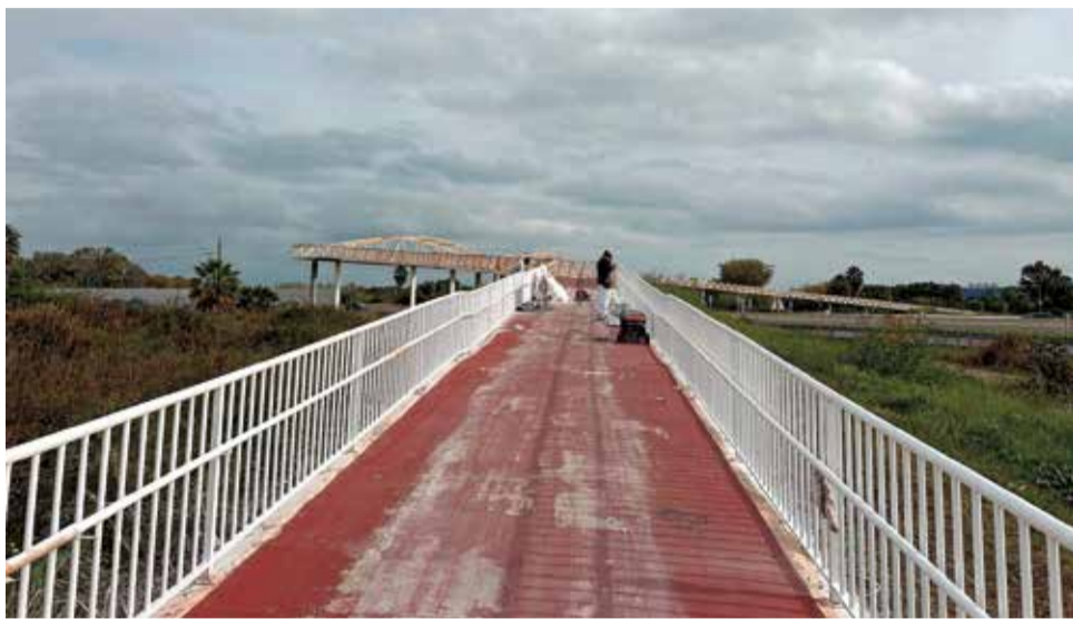
Els treballs que s'estan fent a la passarel·la. / EPDA
