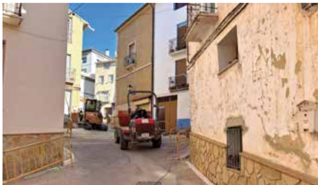
Varios operarios trabajan en las calles de Tuéjar. / EPDA
