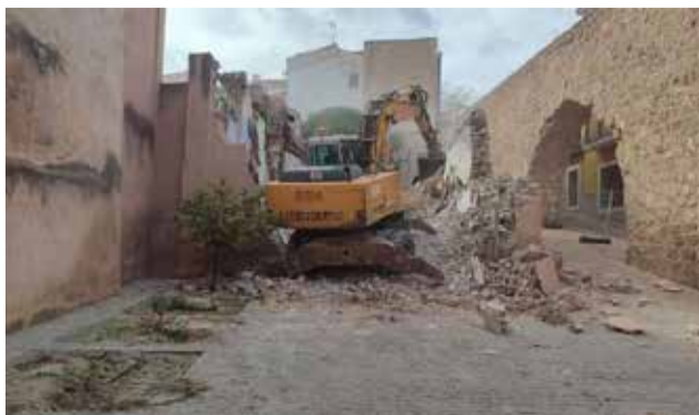
Fotografía del inicio de los trabajos. / EPDA
