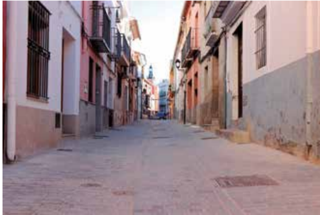
Carrers on s'ha actuat després de les obres. / A. S.
