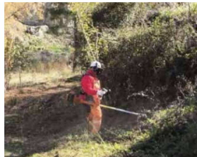
Trabajos de limpieza en los montes de Bejís. / EPDA
