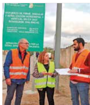
Visita a las obras. / EPDA
