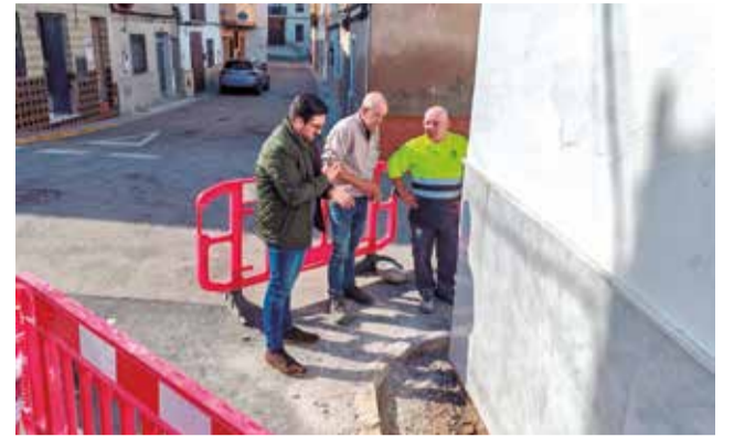
L'alcalde, Héctor Troyano, visita les obres. / EPDA
