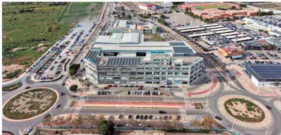
Instalaciones del Centro Comercial Lepicentre. / EPDA
