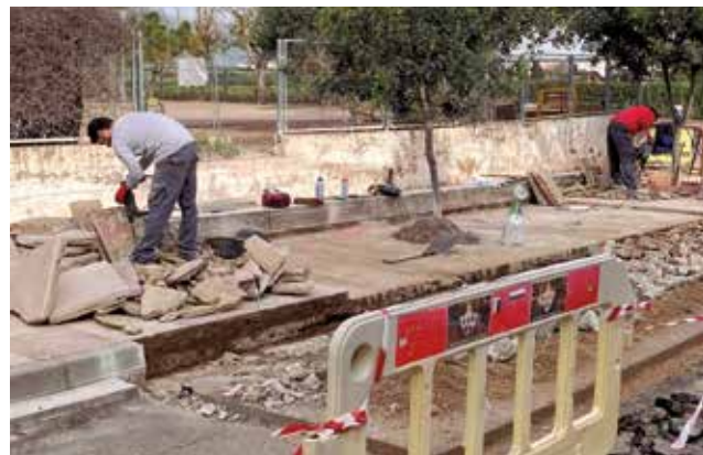
Les obres de la passarel·la. / EPDA
