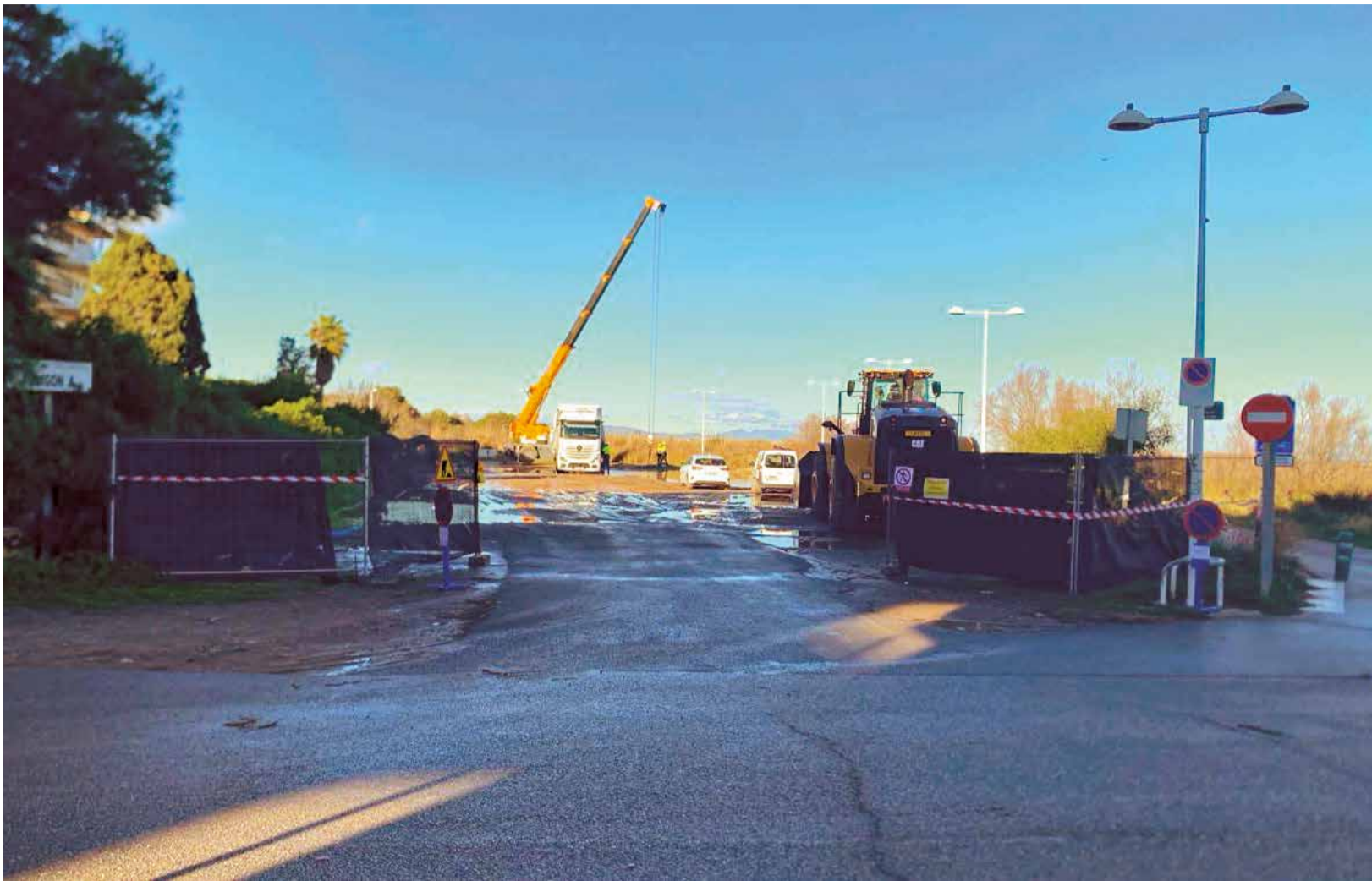
Empiezan a aparecer en el litoral norte del Camp de Morvedre las primeras máquinas que permitirán la inyección de sedimentos. / EPDA
