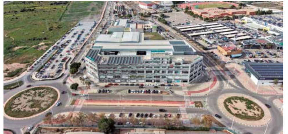
Instalaciones del Centro Comercial Lepicentre. / EPDA
