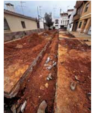
Obras alcantarillado. / EPDA
