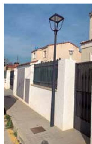
Nuevo alumbrado. / EPDA
