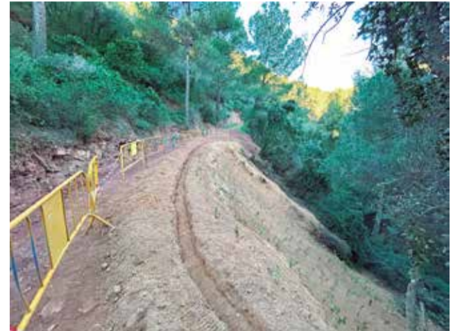
Les obres d'estabilització del talús. / EPDA
