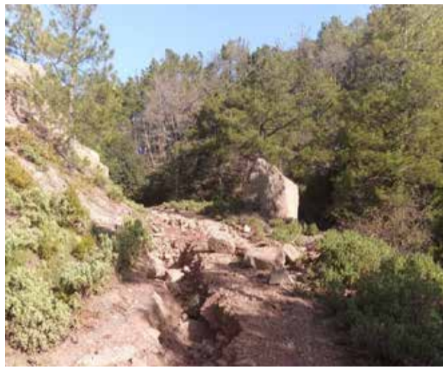
Daños causados por la dana de 2024 en Pina. / EPDA
