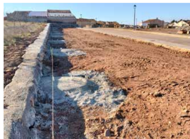
Zona de la Martina donde se ubicará el parking. / EPDA
