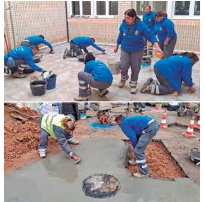
Trabajos de pavimentado en Utiel. / EPDA
