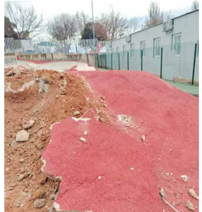
Demolición del skate park de Utiel. / EPDA
