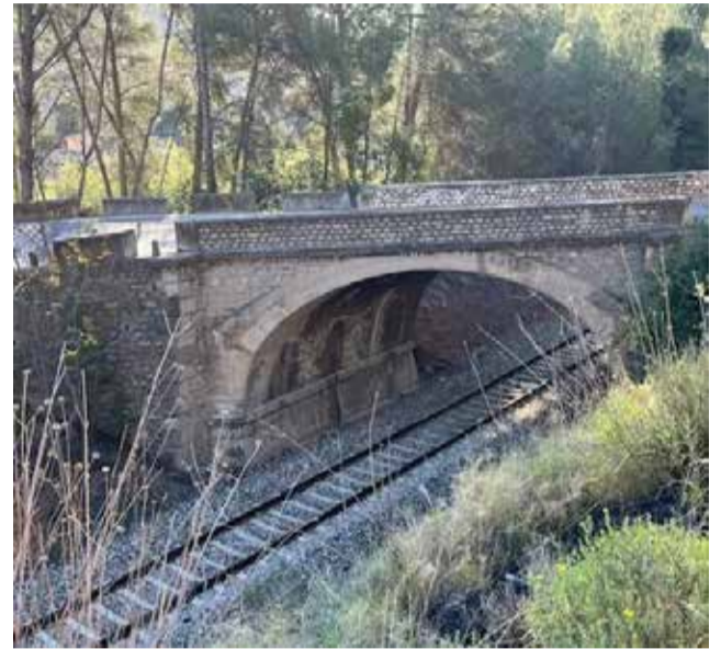
Puente ferroviario de Navajas. / EPDA
