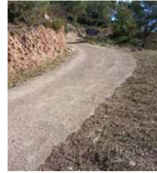
Imagen de los trabajos. / EPDA
