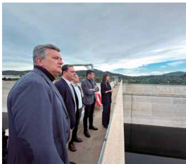
Visita a la depuradora de Peníscola. / EPDA
