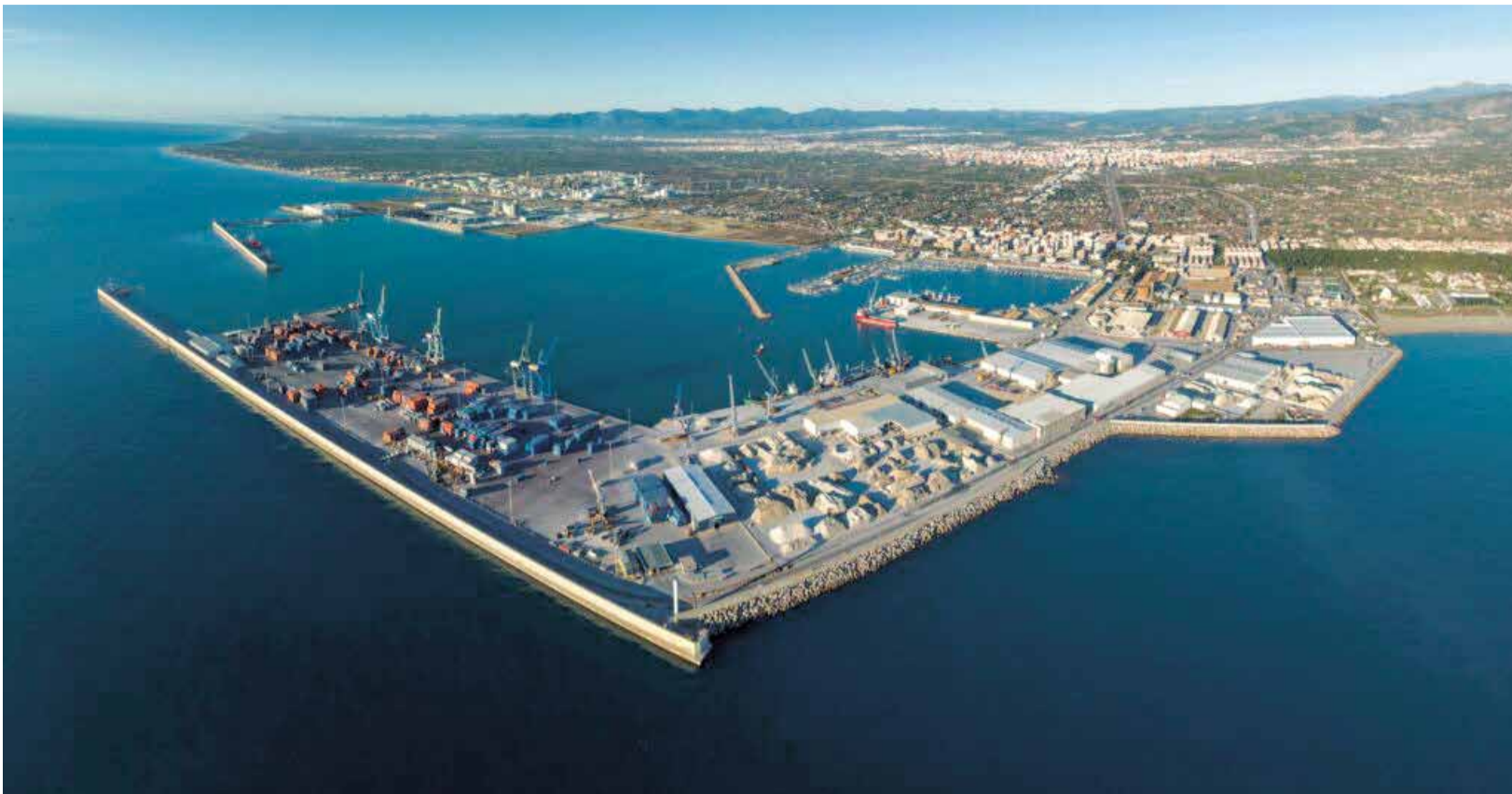
Vista aérea de las infraestructuras del embarcadero del puerto de Castellón. / EPDA
