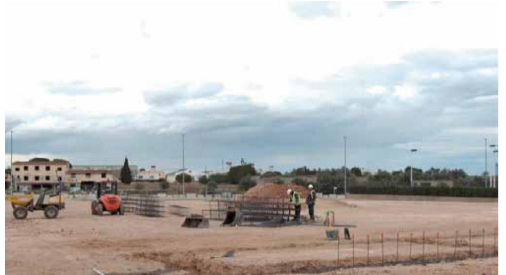
Obras de refuerzo en el ecoparque de Benicarló. / EPDA
