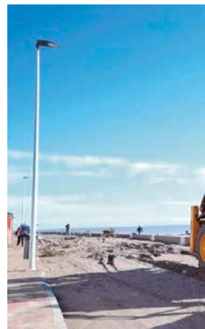
La maquinaria trabaja en Burriana
