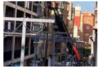
La instalación. / EPDA
