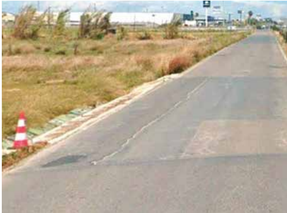
El tram de la carretera on es va a intervindre. / EPDA
