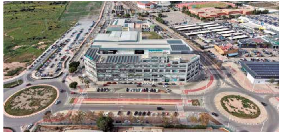
Instalaciones del Centro Comercial Lepicentre. / EPDA
