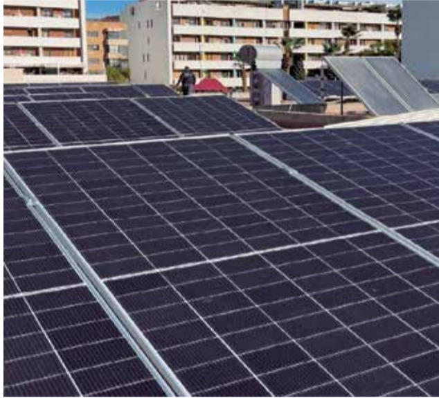
Les plaques solars instal·lades. / EPDA
