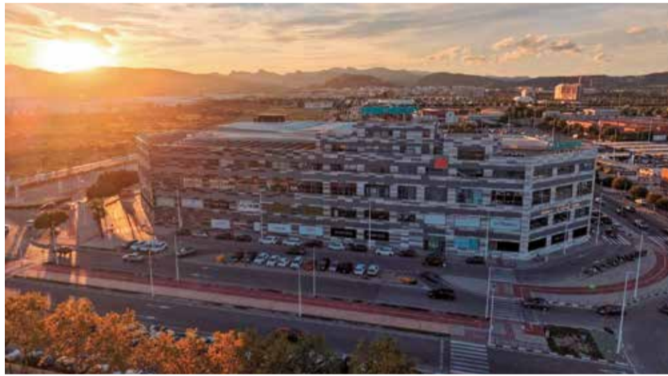
Instal·lacions del Centre Comercial de Lepicentre. / EPDA
