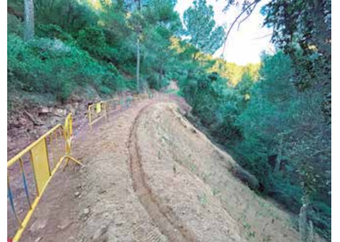
Les obres d'estabilització del talús. / EPDA
