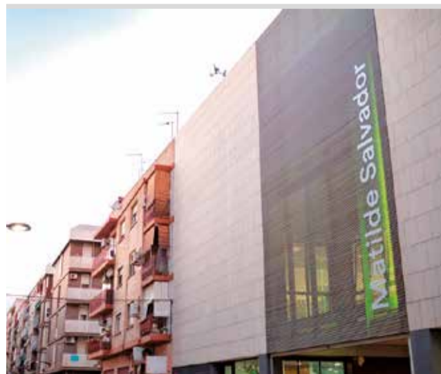
L'edifici Matilde Salvador. / EPDA
