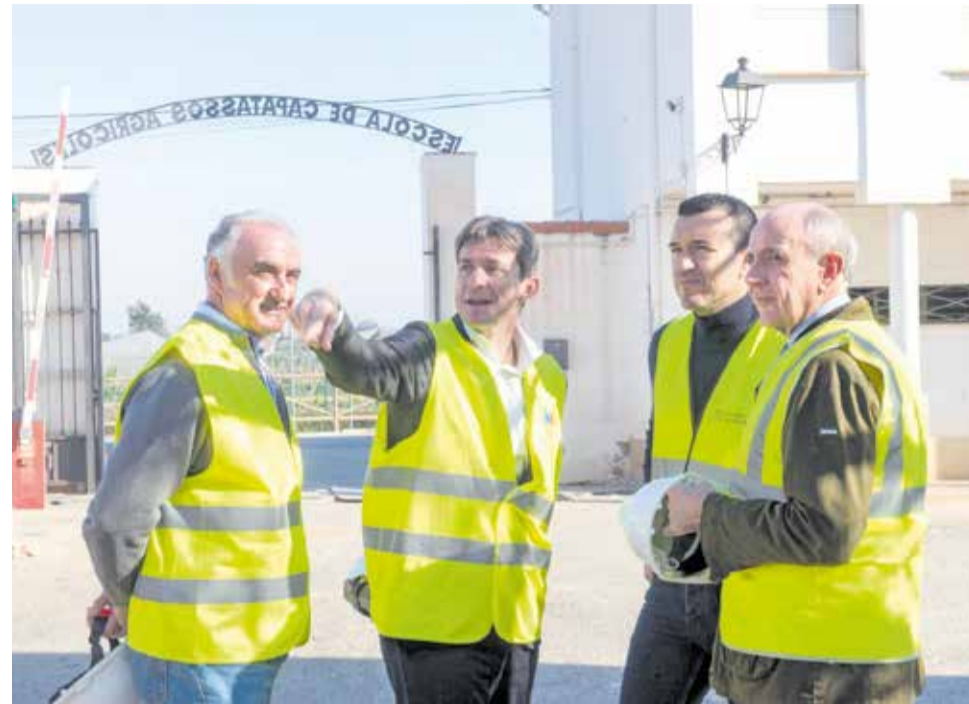
Visita de Mompó i Castresana a les obres de l'Escola de Capatassos de Catarroja. / EPDA
