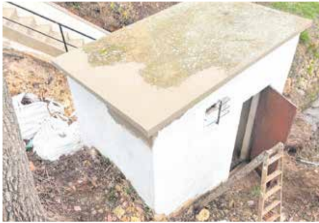
Trabajos de desbroce en Ayora. / EPDA
