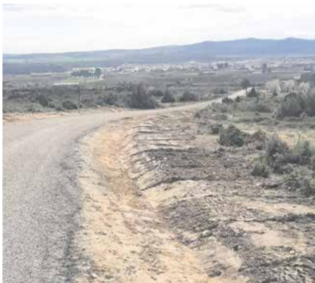
Inicio de los trabajos en el acceso a El Molón. / EPDA
