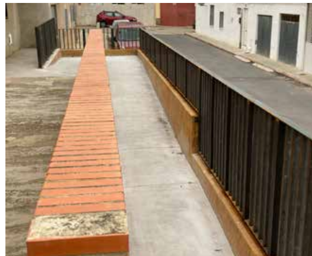
La nova rampa, ja acabada. / EPDA
