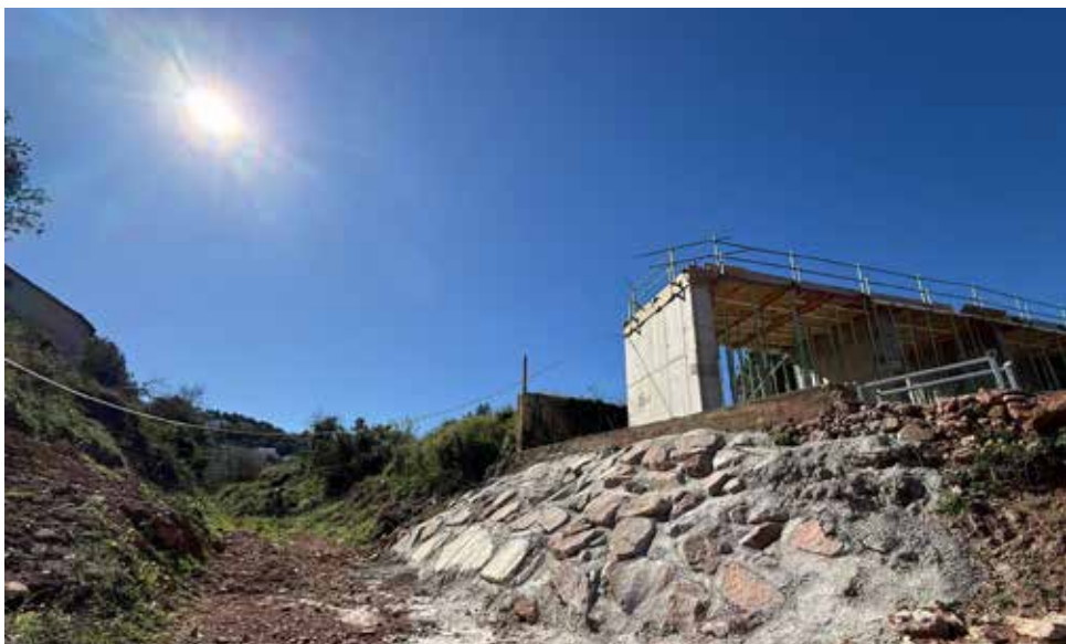
El nou pont sobre el Xocainet unirà la zona esportiva amb el nou pàrquing. / EPDA
