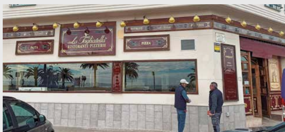
El local de la Tagliatella del Puerto de Sagunto, en reforma / EPDA
