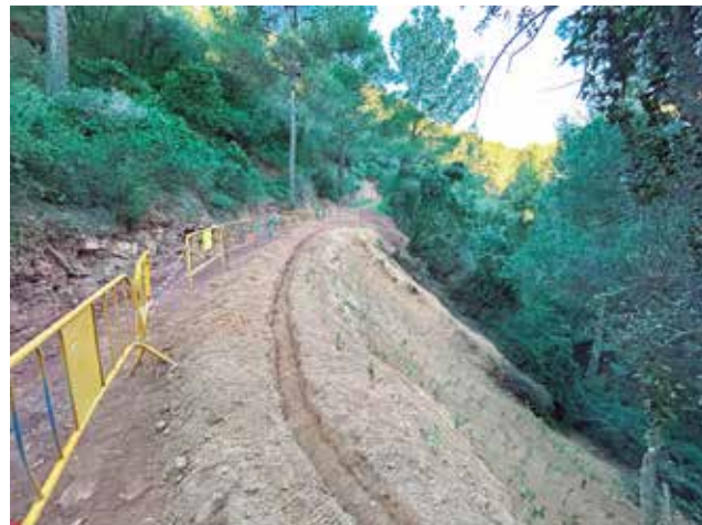
Les obres d'estabilització del talús. / EPDA
