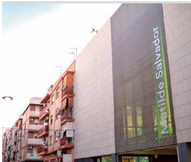
L'edifici Matilde Salvador. / EPDA
