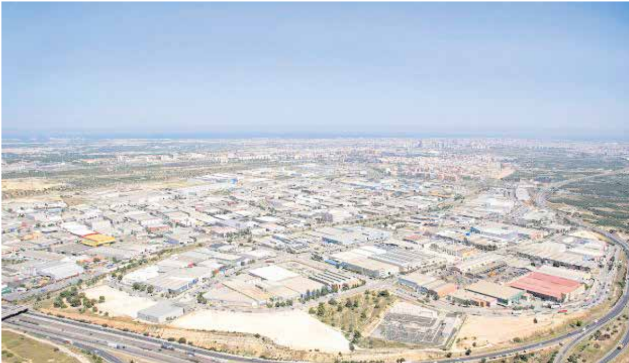
Vista área de las zonas industriales de Fuente del Jarro y Táctica situadas en el término municipal de Paterna. / EPDA
