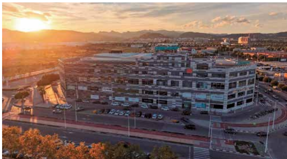
Instal·lacions del Centre Comercial Lepicentre. / EPDA
