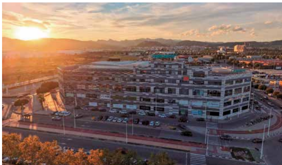
Instal·lacions del Centre Comercial Lepicentre. / EPDA
