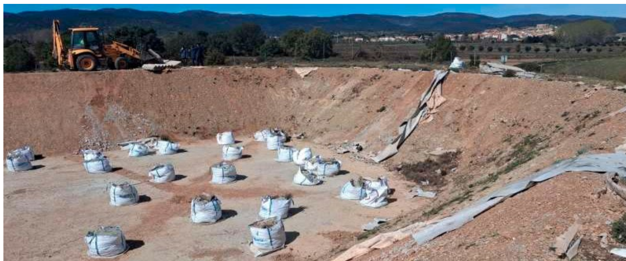
Trabajos de adecuación en la balsa de Villa de El Toro. / EPDA
