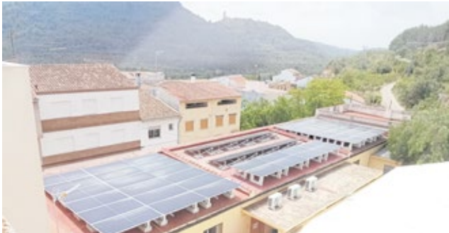
Edificio multiusos de Vall de Almonacid / EPDA
