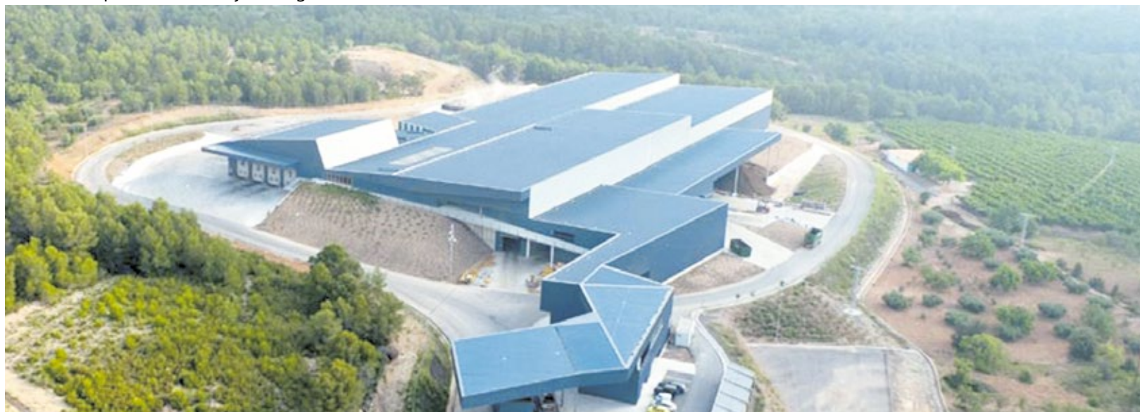
Vista aérea de la planta. / EPDA
