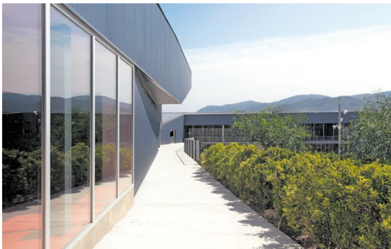
Entrada a la planta de reciclaje de Algímia / EPDA
