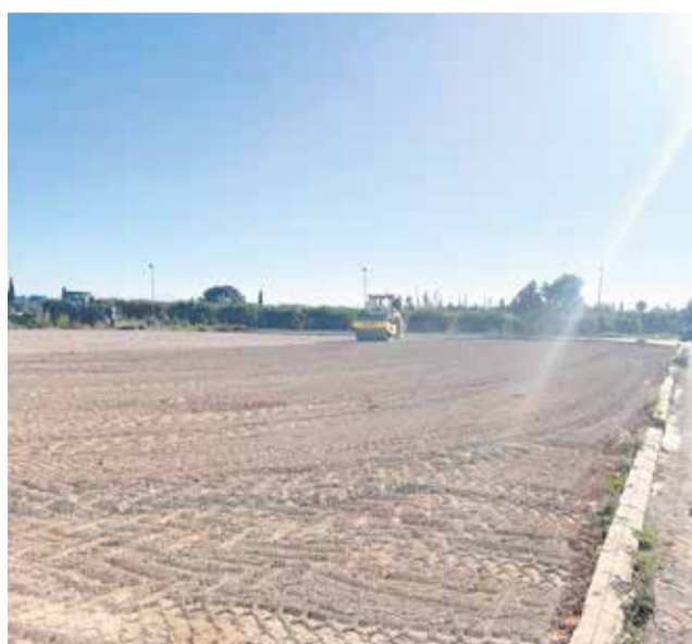
Trabajos entre las calles l'Eliana y Túria. / EPDA
