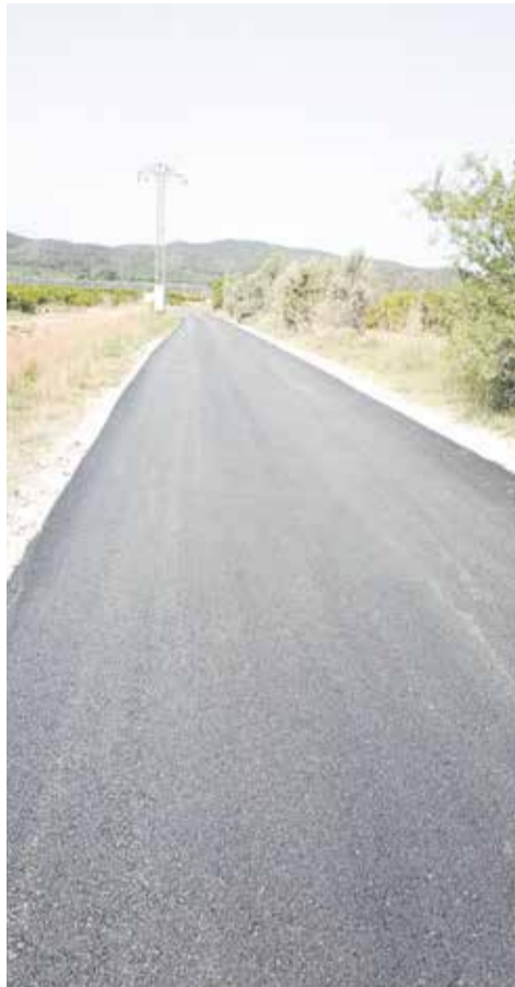
Millores als accessos de la urbanització El Pinar. / EPDA
