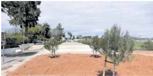
Trabajos en la antigua carretera CV-374. / EPDA
