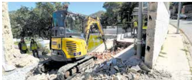
Obres a la piscina municipal de Serra. / EPDA
