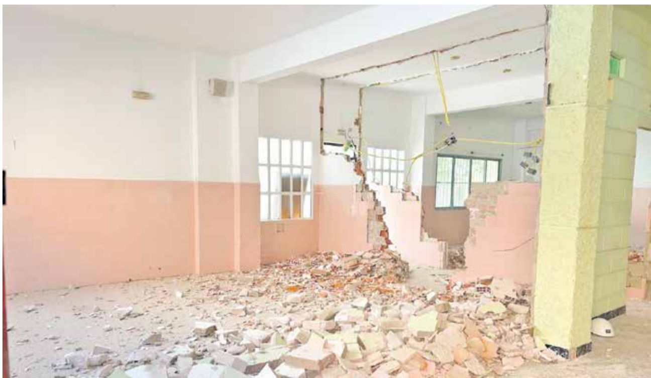
Arrancan las obras para transformar las antiguas escuelas en un centro de Servicios Sociales. / EPDA
