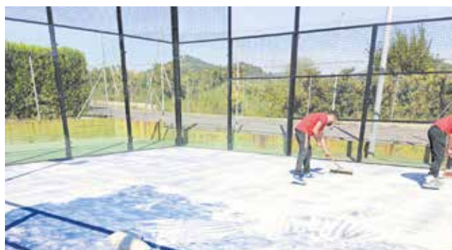
Actuacions de millora en les pistes de pàdel. / EPDA
