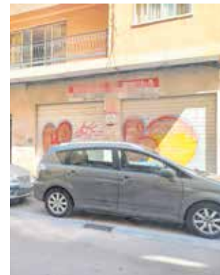
Façana del nou local. / EPDA
