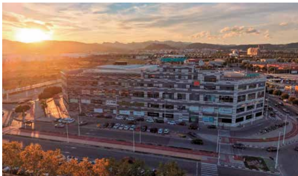
Instal·lacions del Centre Comercial Lepicentre. / EPDA
