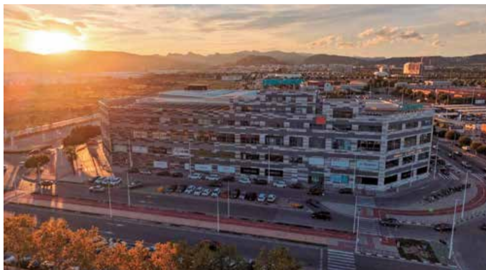
Instal·lacions del Centre Comercial Lepicentre. / EPDA
