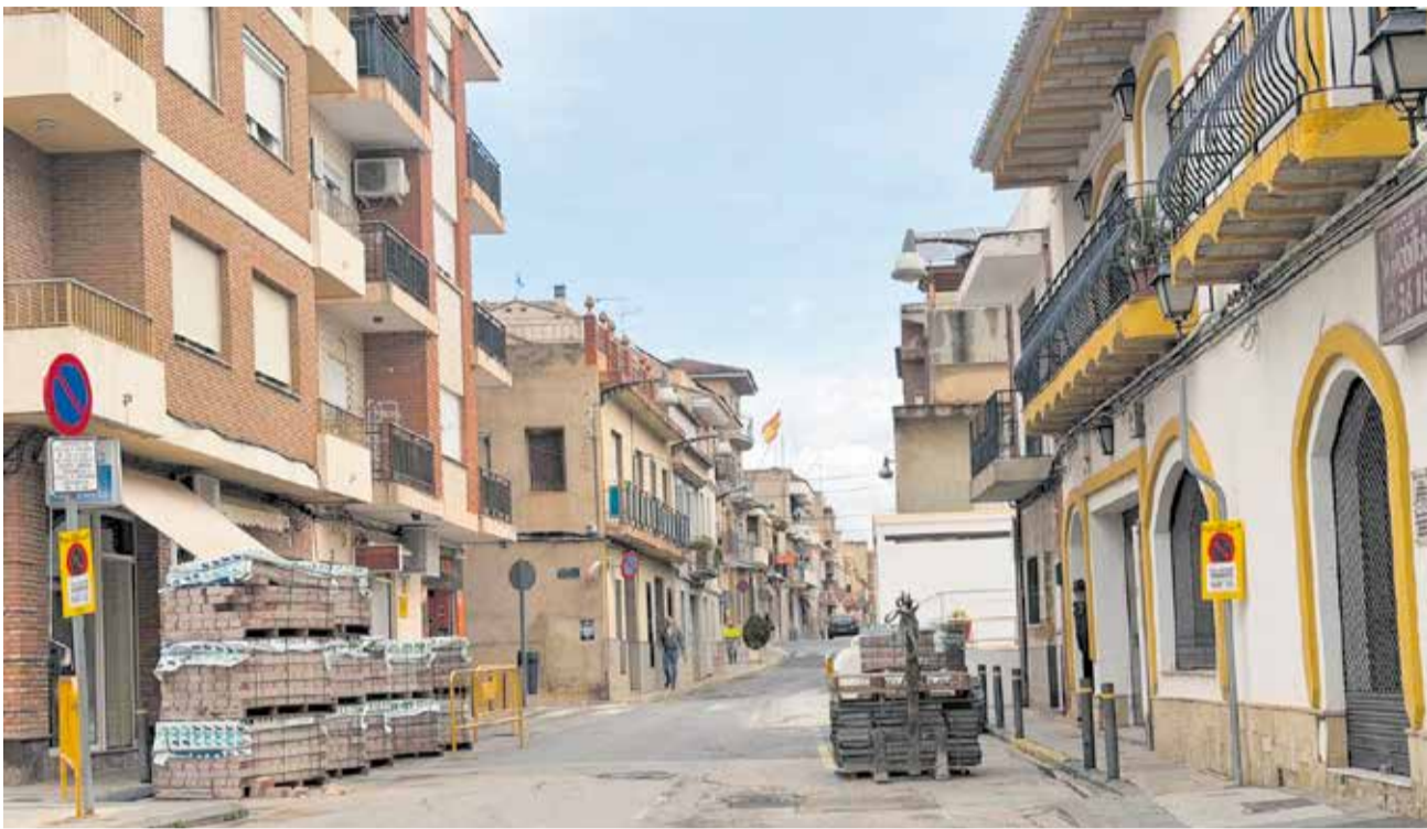
Inicio de las obras en la avenida Colón, la principal arteria de la Pobla de Vallbona. / EPDA
