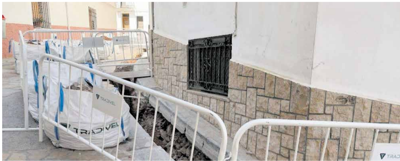
Trabajos en una de las calles de Montanejos. / EPDA
