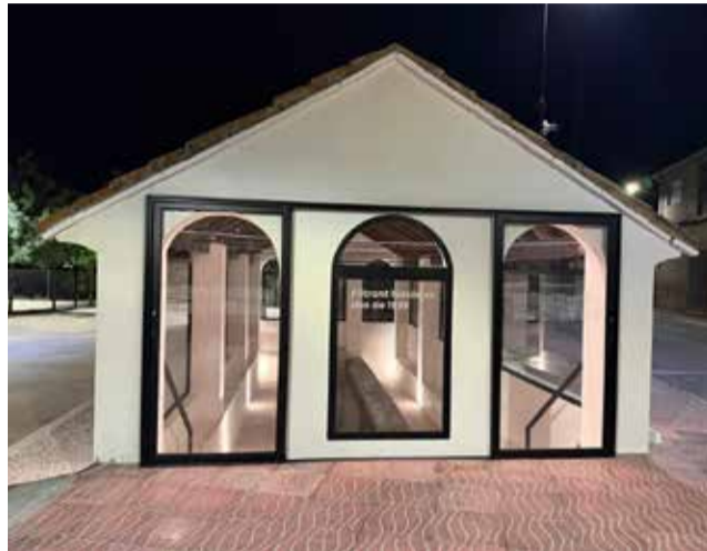
Nou llavador municipal de Cerdà./ EPDA
