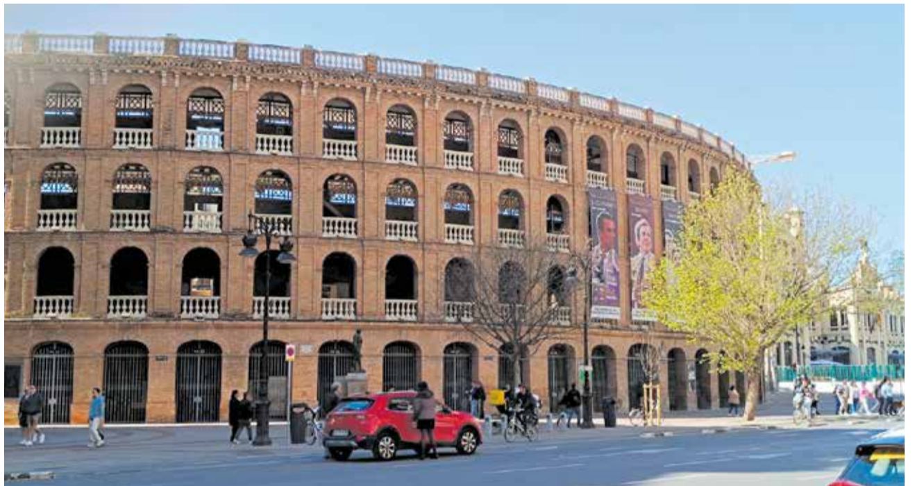
Fachada de la Plaza de Toros en la calle Xàtiva. / HÉCTOR GONZÁLEZ
