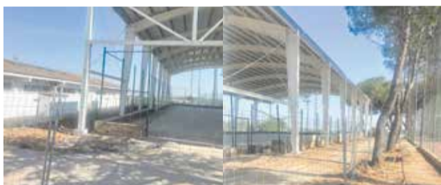
Trabajos en el recinto. / EPDA
