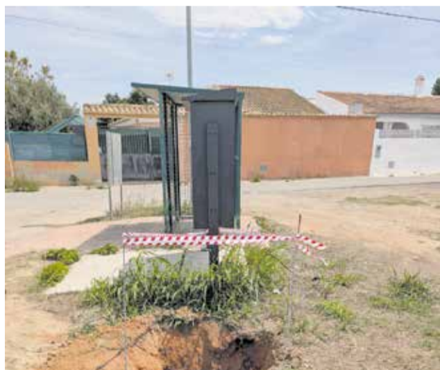
Treballs d'instal·lació de panells digitals. / EPDA
