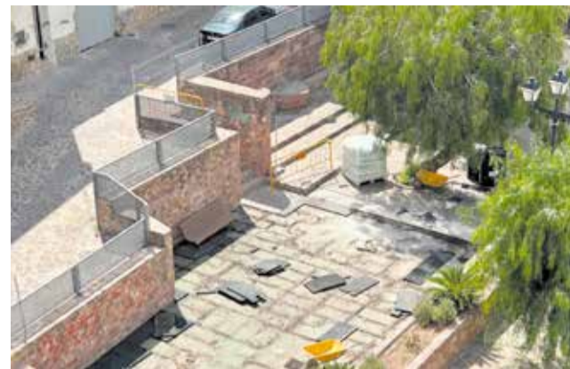
Obres en la Plaça de la Font de Serra. / EPDA
