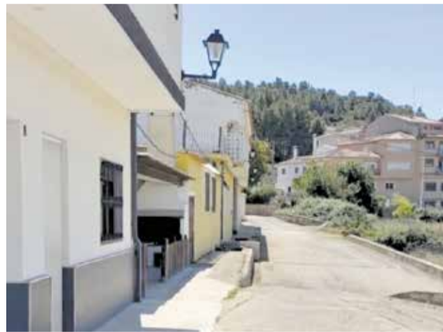
Calle Fuente del Saz de Tuéjar. / EPDA
