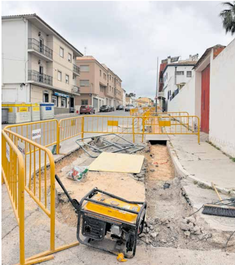
Obras en la Ronda La Baronía de Villar del Arzobispo. / EPDA
