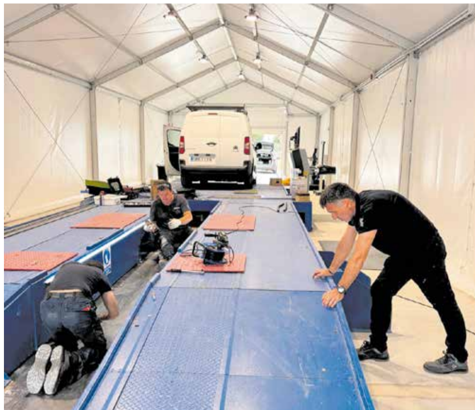
Las instalaciones que albergarán la ITV permanente en Segorbe. / EPDA
