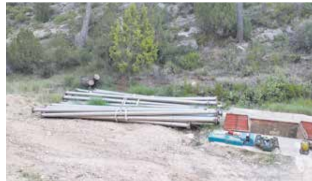
Nuevas tuberías de acero inoxidable. / EPDA
