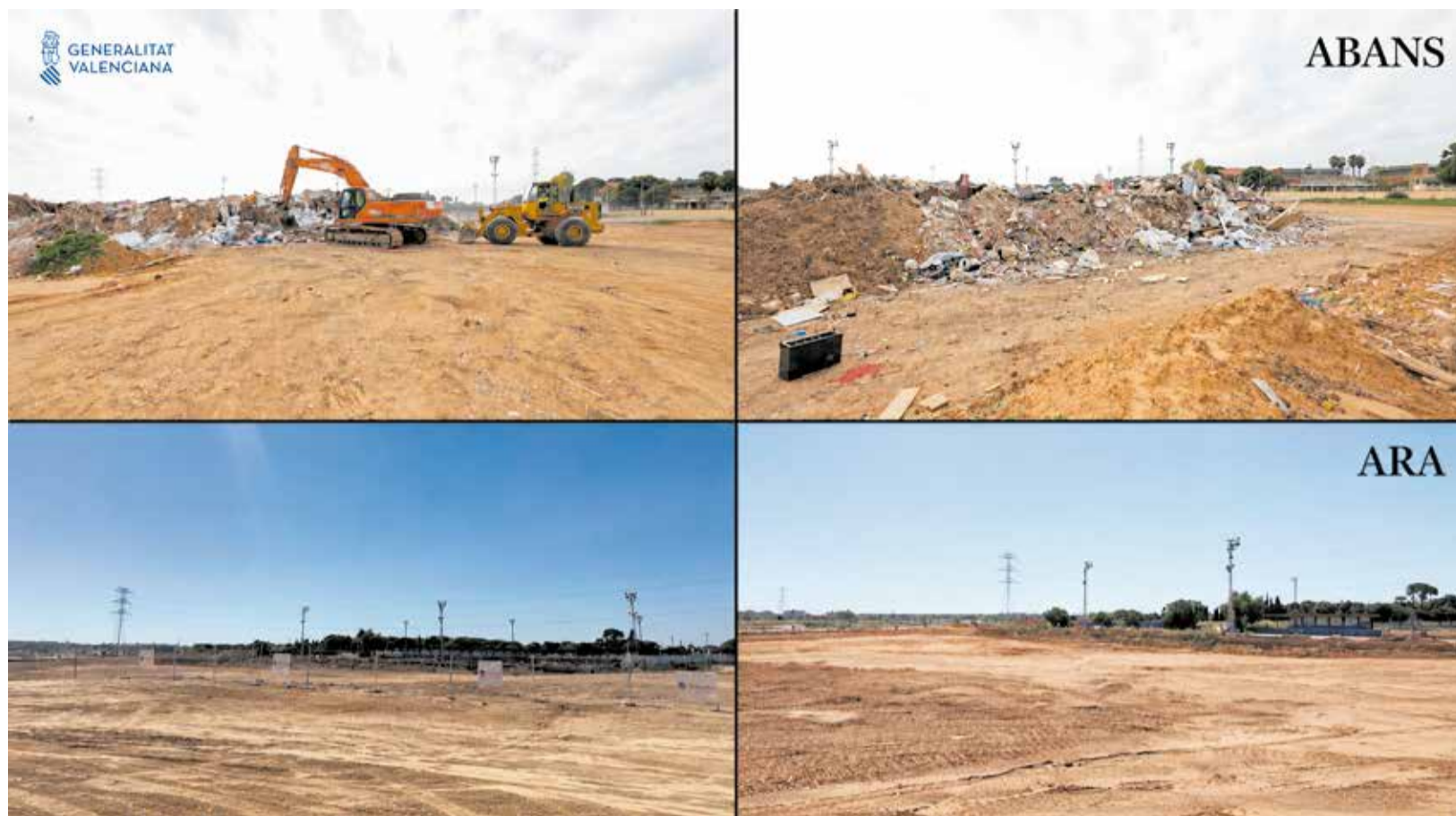
Comparació del punt d'apilament de Paiporta tenint en compte "l'abans i el després" dels treballs de recollida dels enderrocs de la dana. / EPDA
