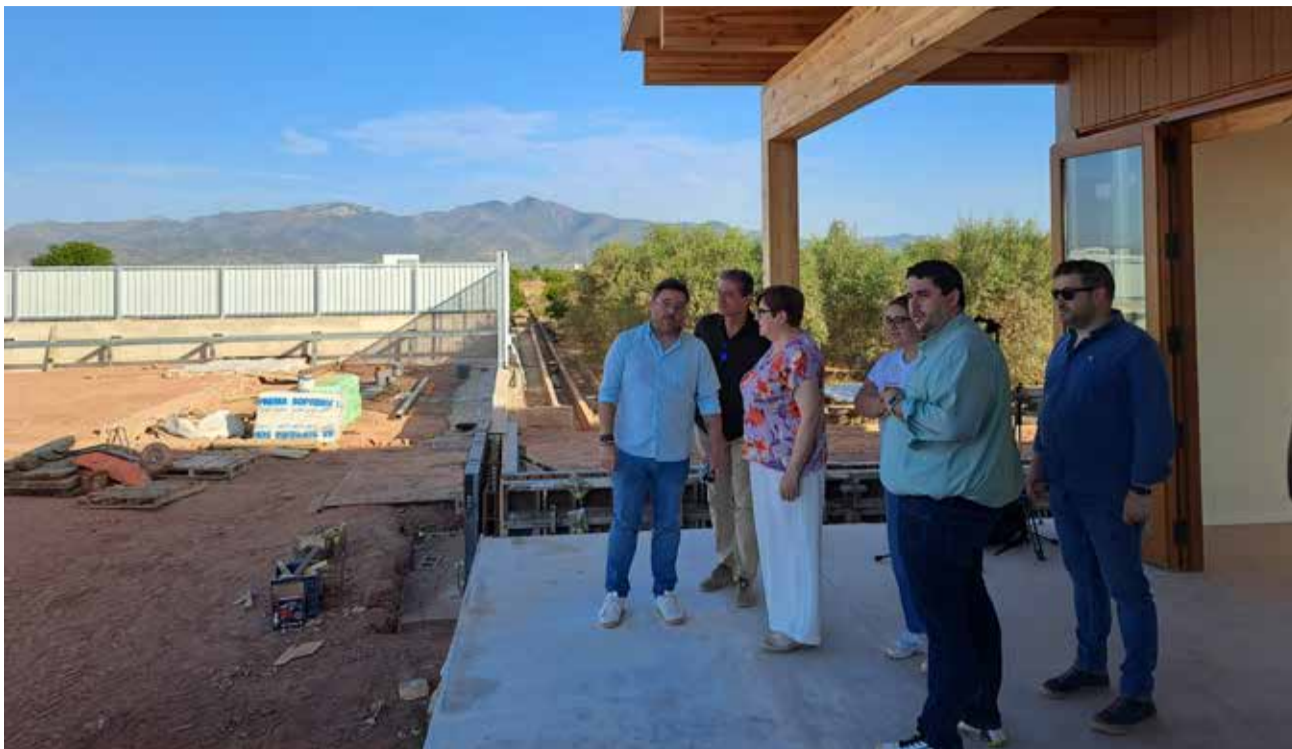
Visita a les obres de la Vila Romana del Benicató. / EPDA
