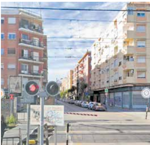
Paso a nivel de Alfafar-Sedaví. / EPDA
