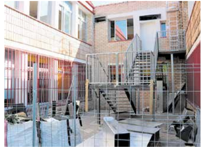
Obras en un centro educativo. / EPDA
