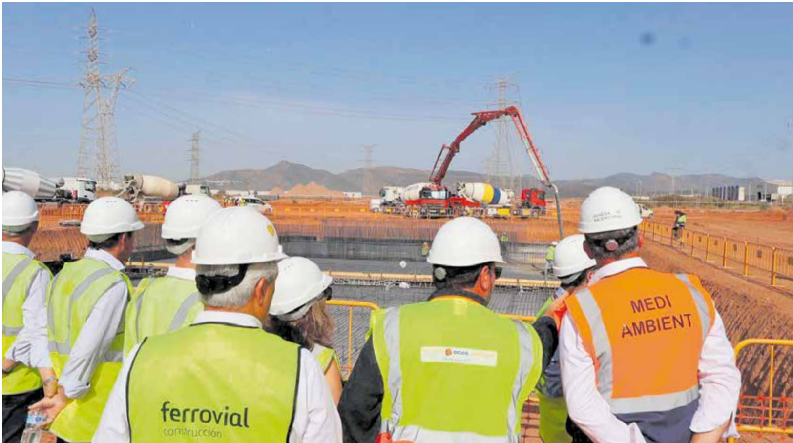
Las obras de la depuradora que dará servicio a Sagunt, Estivella, Gilet, Petrés y Albalat dels Tarongers. / EPDA
