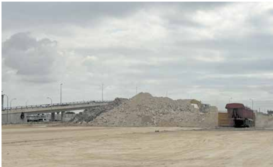
Primeros trabajos realizados en junio del futuro L'Alter Business Park. / J. ZALDIVAR
