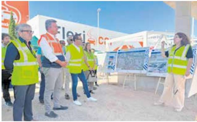
Visita de les autoritats institucionals a les obres. / EPDA
