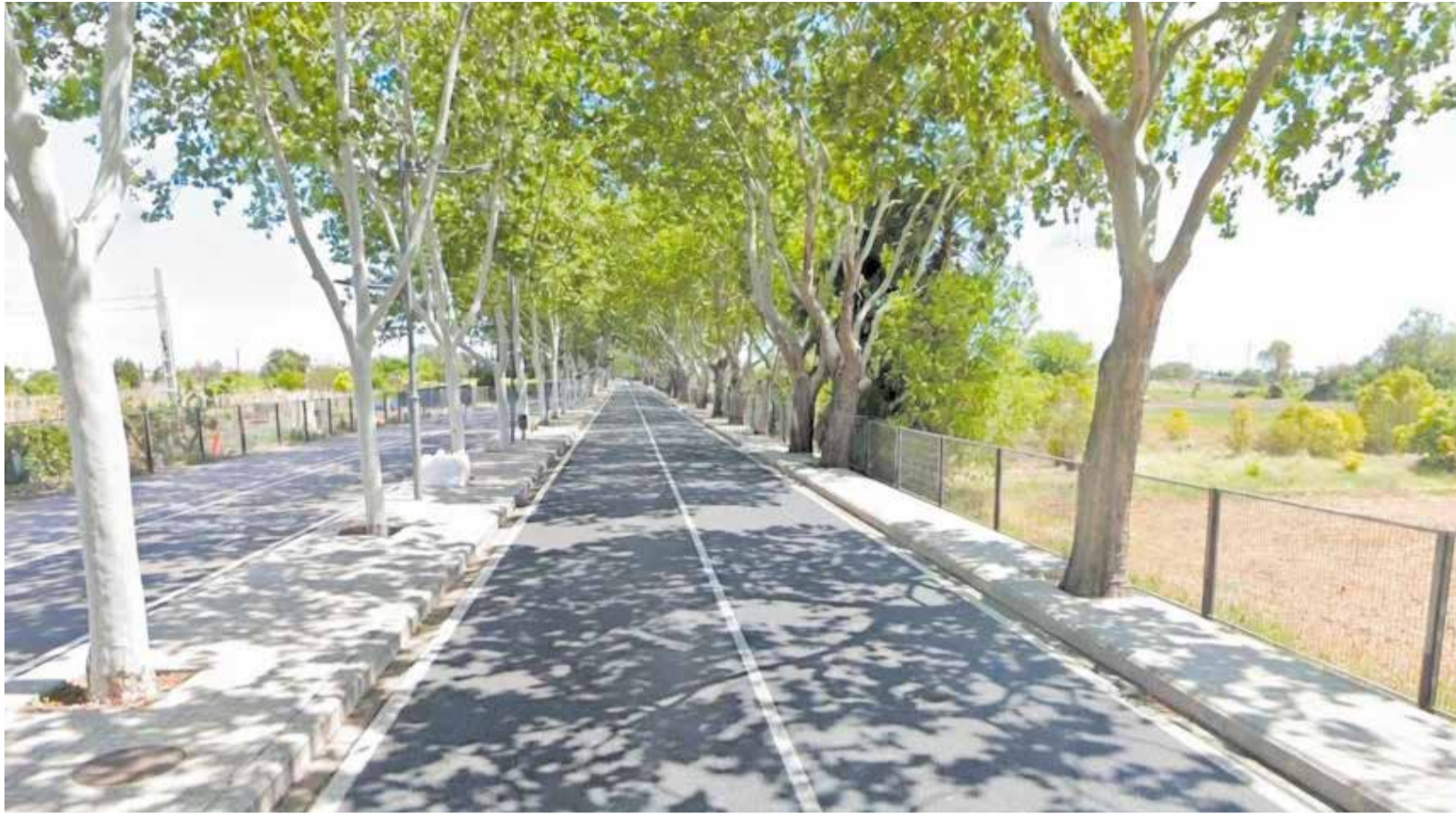
La carretera CV-409 que connecta Aldaia amb la localitat veïna de Xirivella i per on passarien els autobusos. / EPDA
