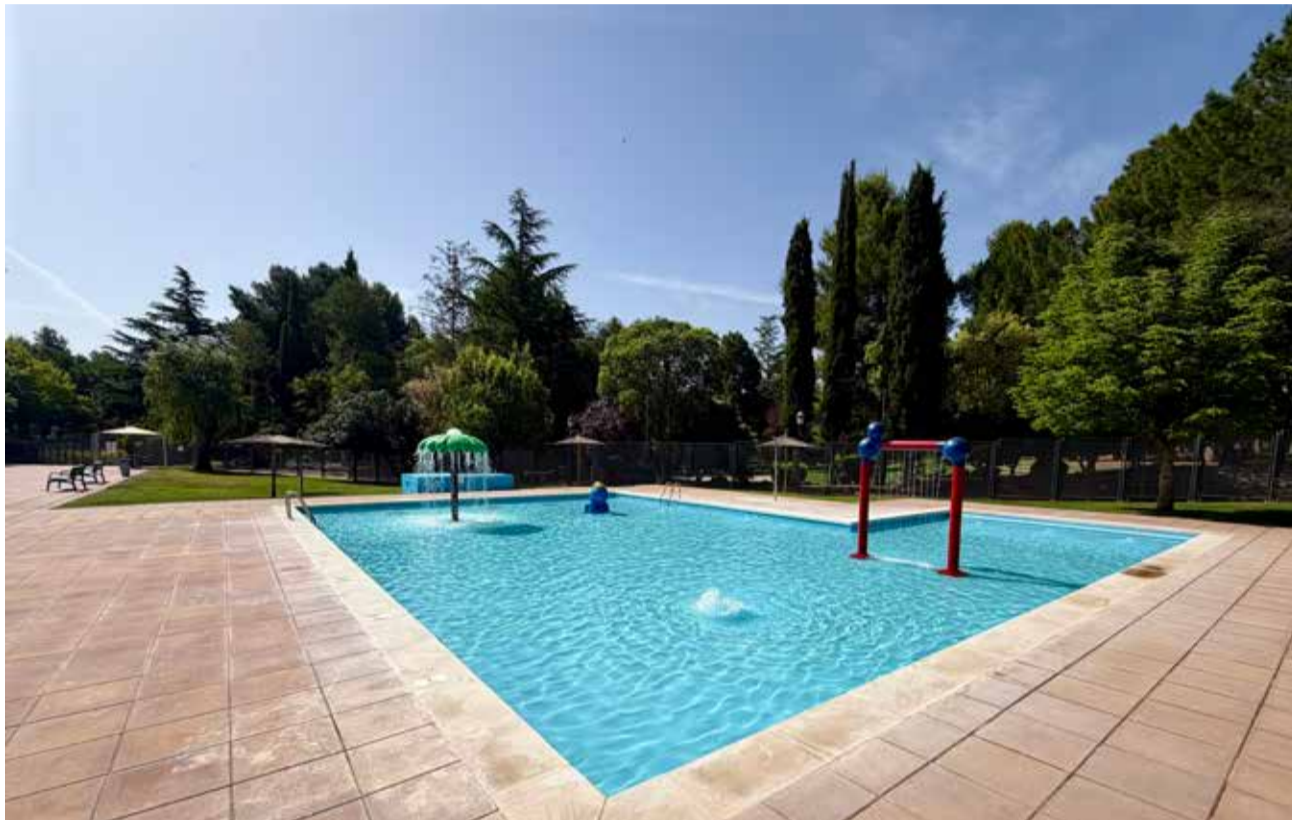
Las piscinas municipales de Utiel ya están abiertas al público tras las actuaciones. / EPDA
