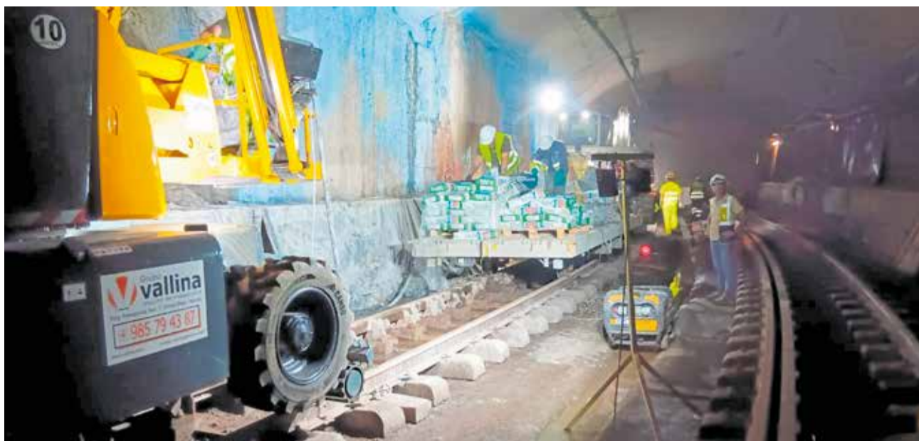
Obres de millora en una línia de Metrovalència. / EPDA
