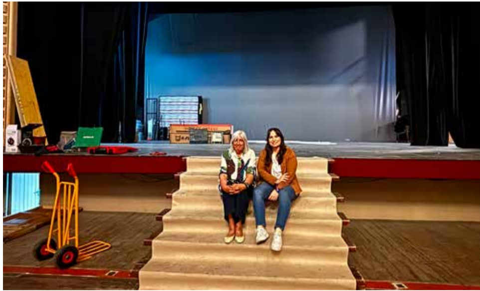
Obras de climatización en el Teatro Principal de Requena. / EPDA
