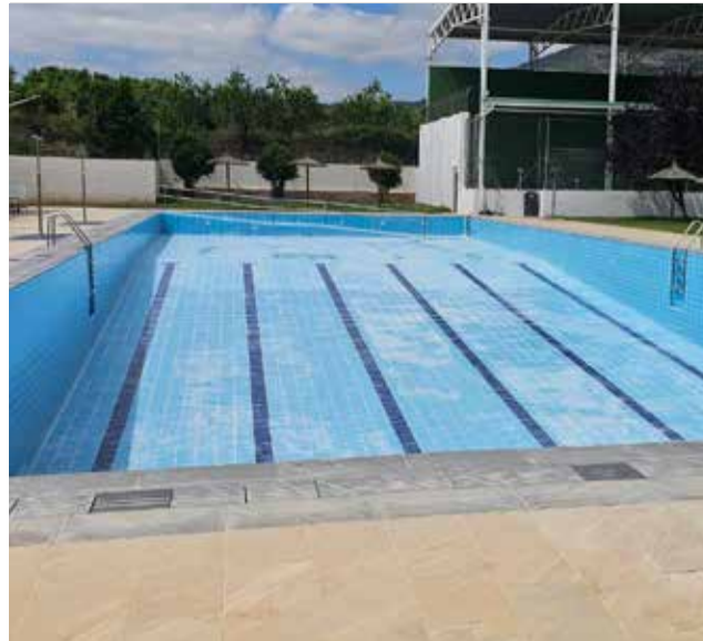
Obras de renovación en la piscina de Chera para esta jornada estival. / EPDA
