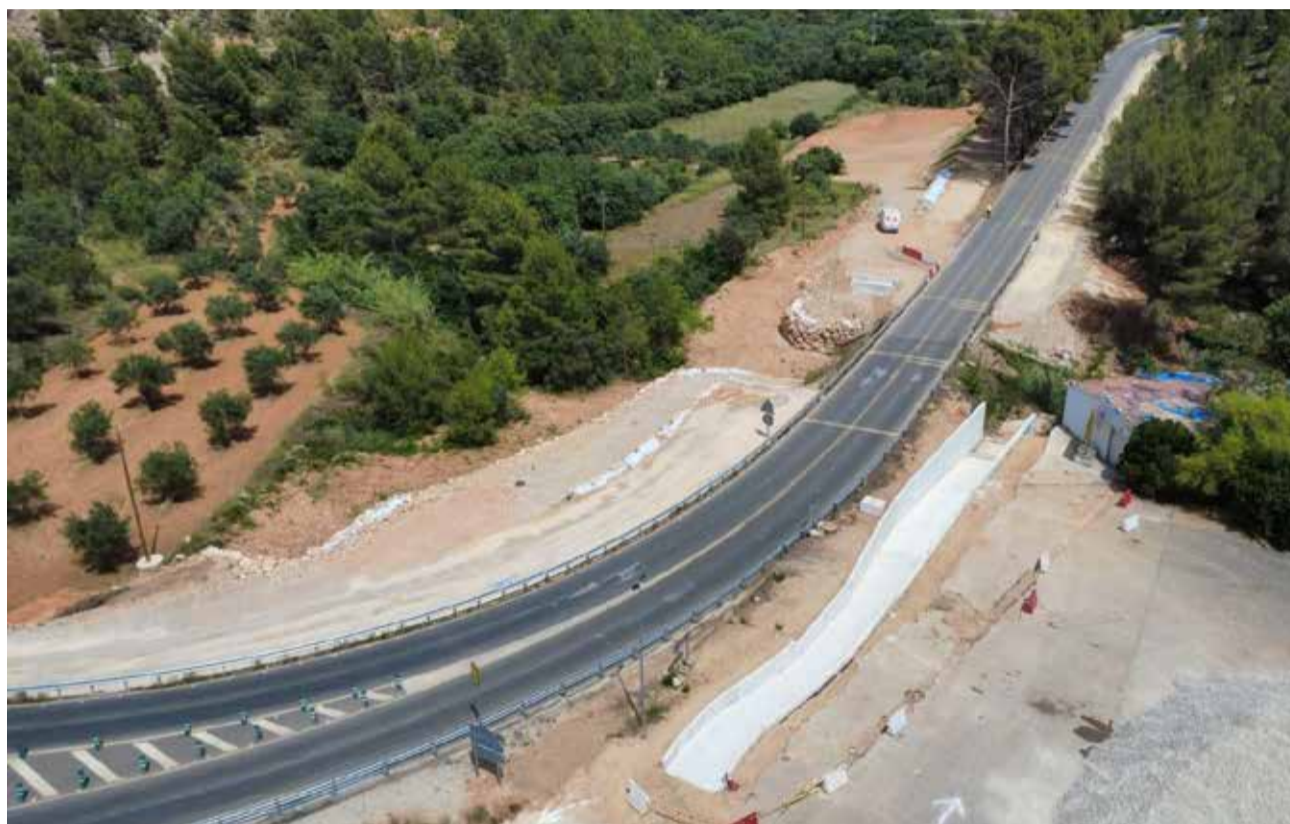
Obras en la carretera CV-425 que une Buñol y Alborache. / DIPUTACIÓN DE VALENCIA
