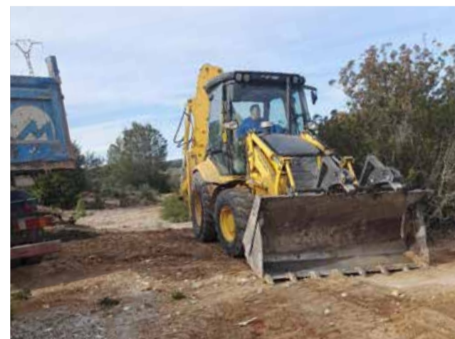
Trabajos de retirada de vertidos ilegales. / EPDA
