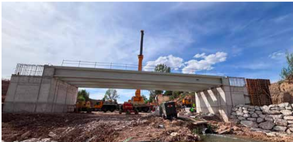
Obras de reparación del puente de La Vega y San Antonio tras la dana. / EPDA
