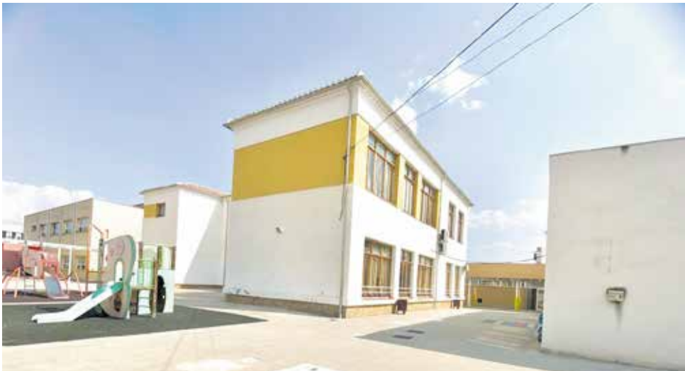
Colegio público de Casinos La Pau. / EPDA
