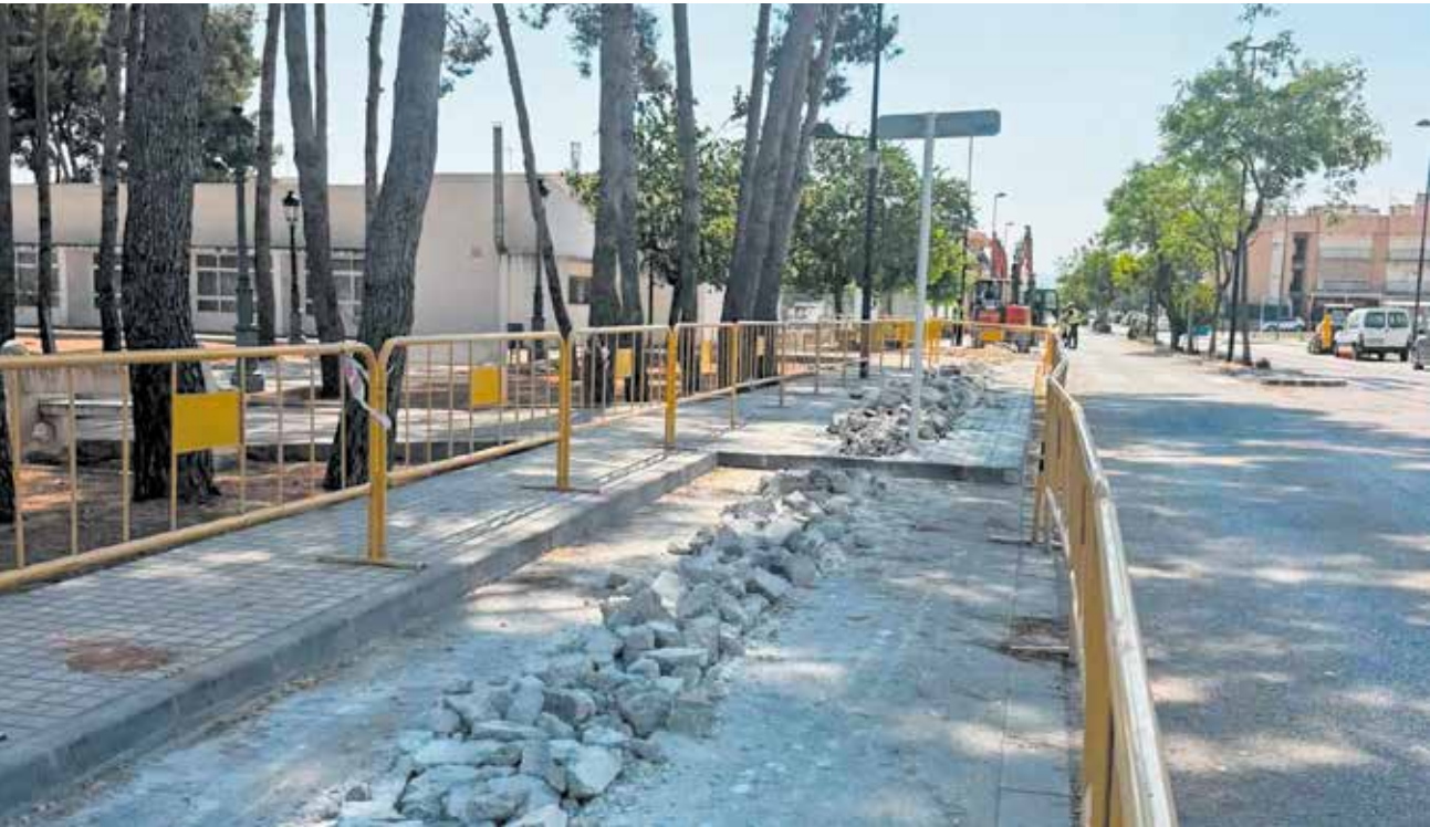
Obras en la red eléctrica de Loriguilla. / EPDA
