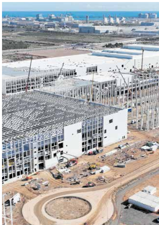
Obras de la gigafactoría en Sagunt. / POWERCO
