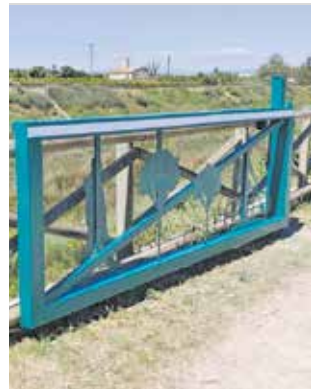
La puerta instalada. / EPDA
