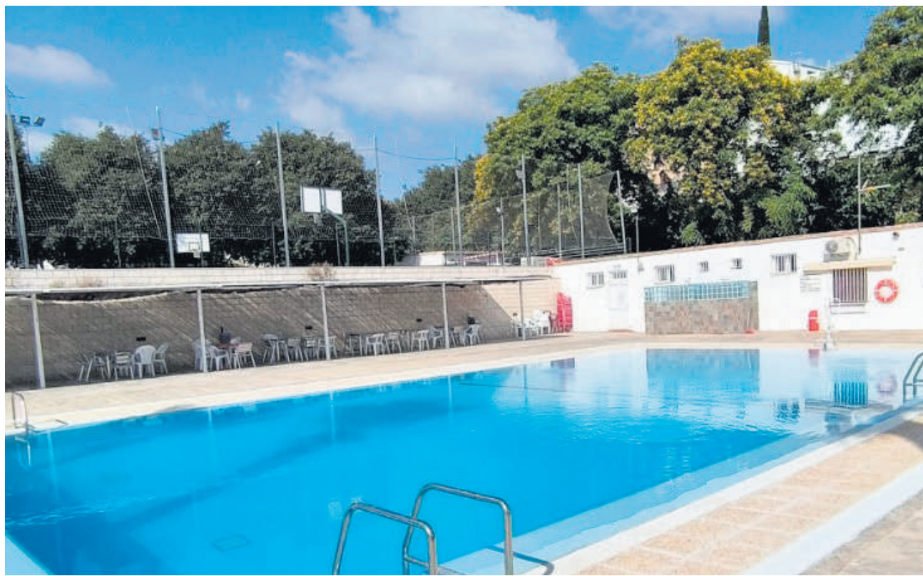
La piscina de Vallés després de les millores realitzades a l'equipament municipal. / EPDA
