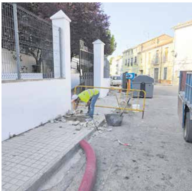
Obras de instalación del punto de recarga. / EPDA
