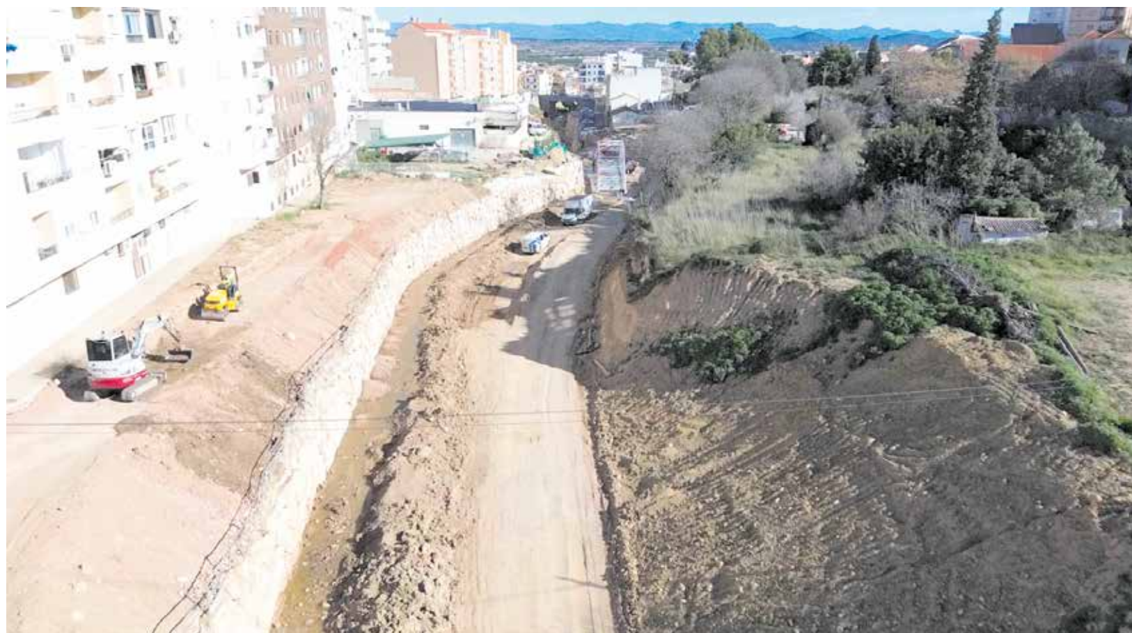
Obras de reparación en el barranco del Poyo a su paso por el casco urbano de Chiva tras los daños causados por la dana. / CHJ
