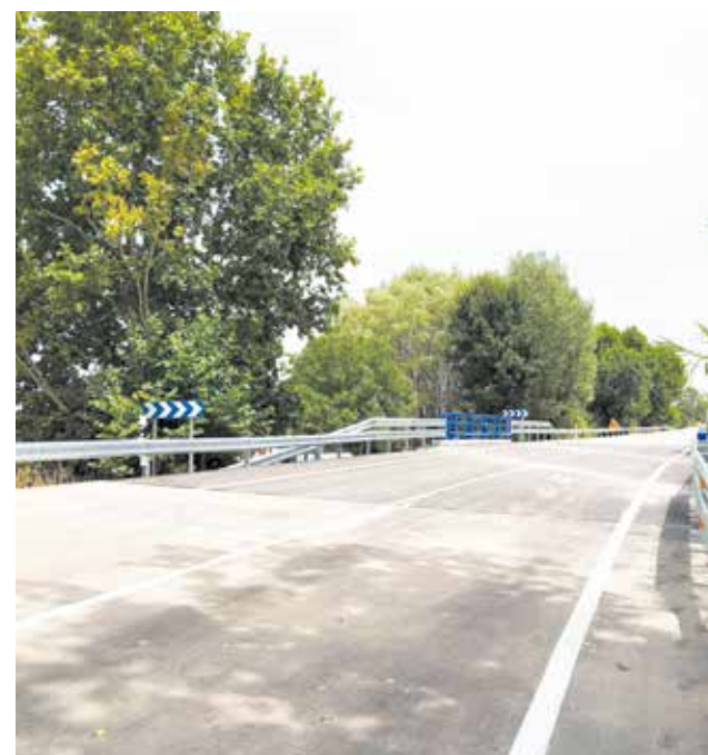
Tramo de la N-3 que pasa por el río Madre. / EPDA
