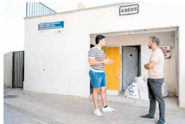
Falomir i Torner, durant la visita a les obres. / EPDA
