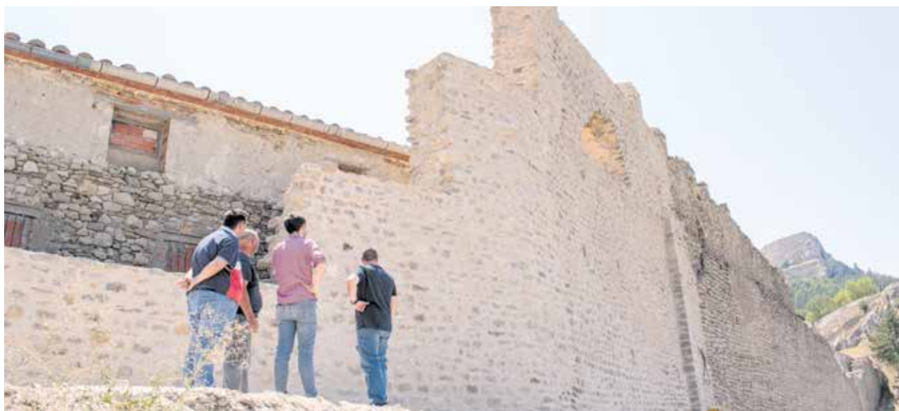
Visita a les obres de l'aqüeducte. / AJUNTAMENT DE MORELLA
