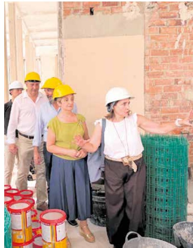
La consellera Marián Cano, durant la visita a les obres. / EPDA
