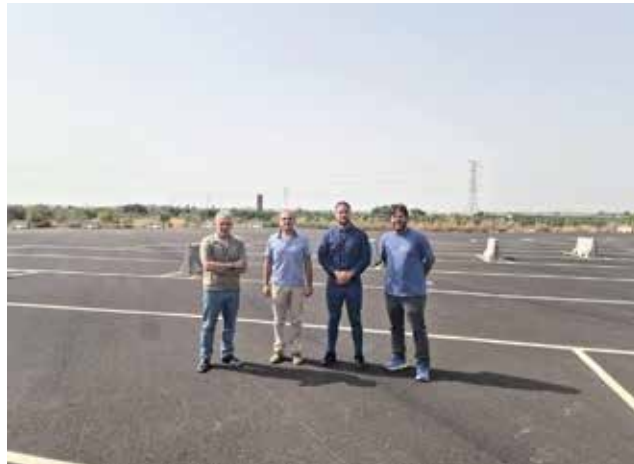
Nuevo parking en el polígono Los Vientos. / EPDA
