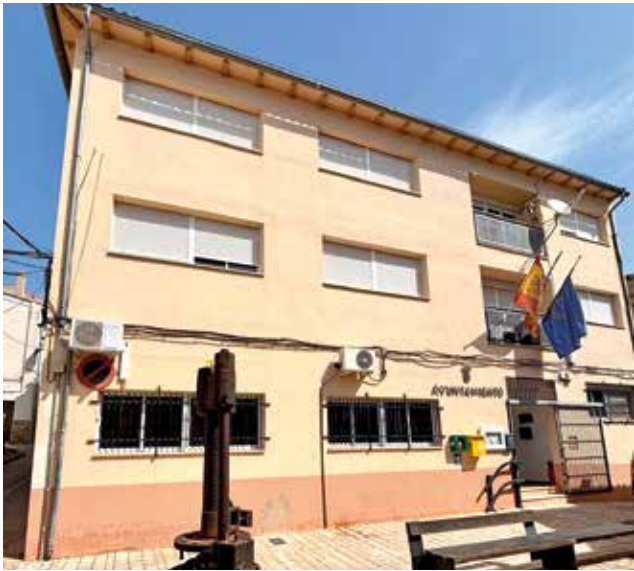
Estado actual del ayuntamiento de Casas Bajas. / EPDA
